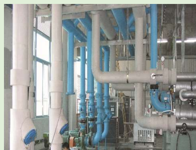
室内设备安装后
