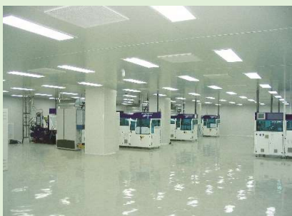
无尘车间完成品
