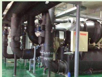
室内设备安装后
