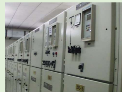
动力设施电柜安装后
