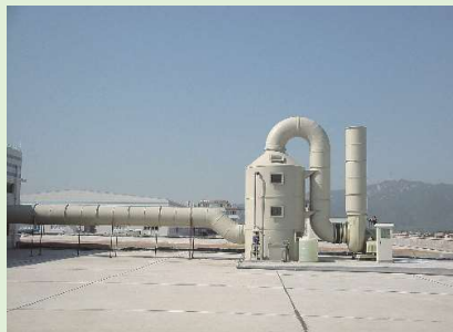
室外设备安装后
