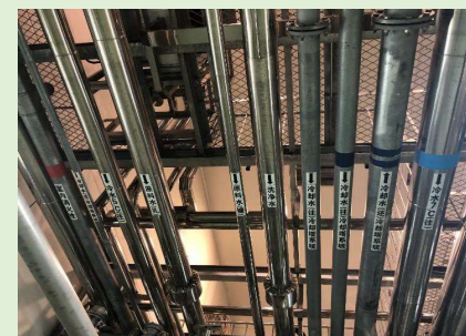
风管水管安装
