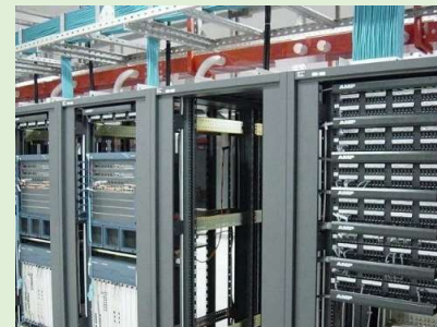
服务器设施安装后
